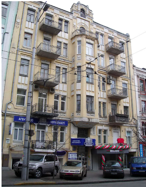
Рис. 3. Будинок на вул. Шота Руставелі, 29, в якому розміщувалося правління ЄЕТ. 2006 р. Фото М. Кальницького
