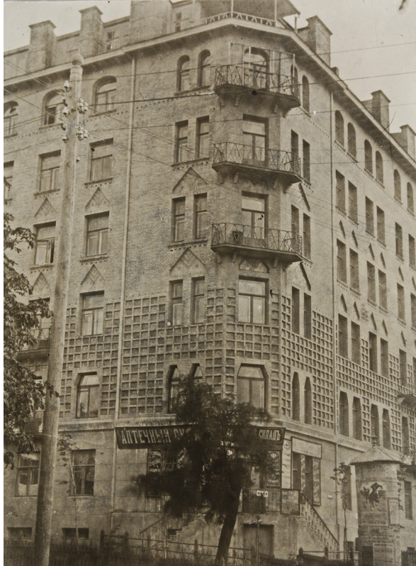
Рис. 1. Прибутковий будинок родини Грушевських у Києві на вул. Паньківській, 9/14. Проєкт фасаду В. Г. Кричевського. [1912]. Фотограф невідомий
